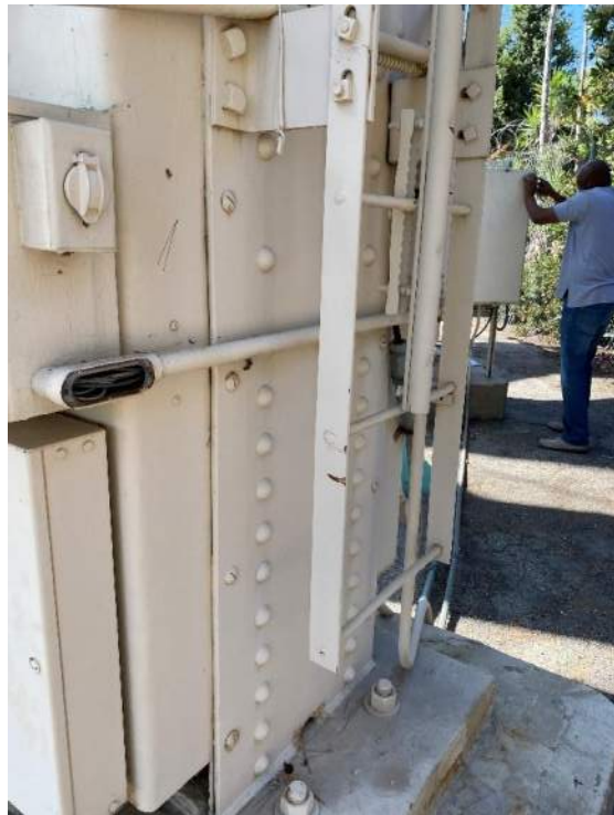
(Bil-16) Tank Access Ladder
